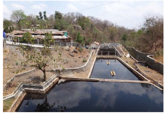
写真-5 浸出水処理施設
