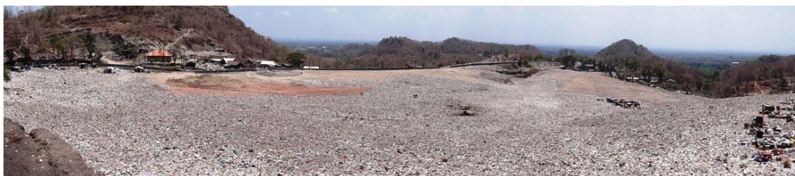
写真-3 処分場全景
