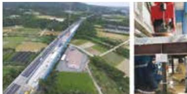
高速道路におけるリニューアル工事と、性能確認のための輪荷重走行試験
