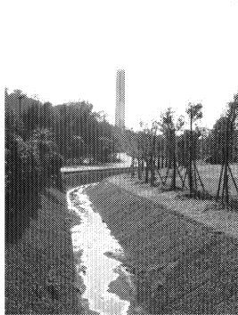
図13 福徳復育公園の滲出水収集施設
