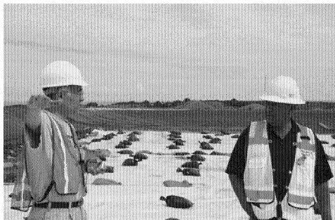
写真1 造成中の埋立地
